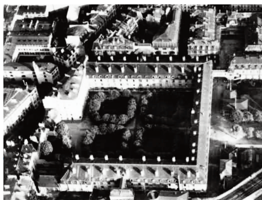
Cliché aérien de l'Hospice des Quinze-Vingts, vers 1950
